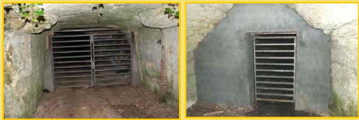
Figuur 5.1 Goede afsluithekken, de linkse foto is de grot aan het Lacroixbosje (foto's: Joachim De Maeseneer).
